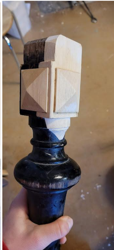
Pilt 9 Parandatud toolijala tapp ja taastatud tahukakujulised puidulõiked
