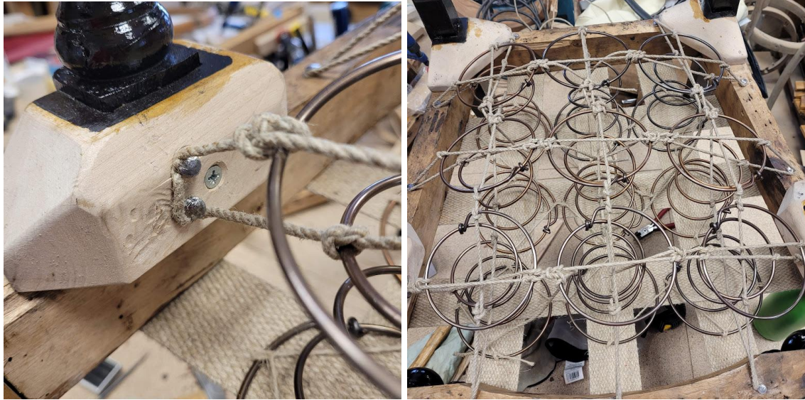
Pilt 28 ja 29 Vedrude pingutamine toolisarjale
