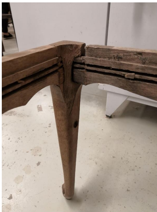
Foto 4. Vasakust tapipesast on kild eraldunud
