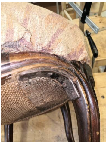
Foto 9. Parandus toolijalal metallplaadiga
