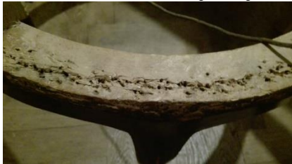
Foto 34. Naeladest puhastatud istmeraam
