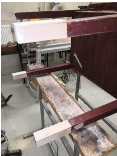
Foto 11. Proteeside mõõtu lõikamine
