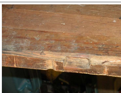
Kapi vasakpoolne uks. Luku keelepessa (tükk murdunud)
