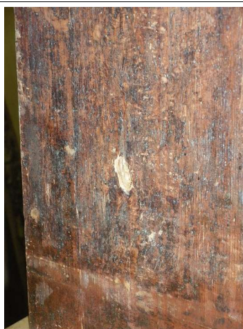
Läbiv auk kapi seinas peale värvi eemaldamist
