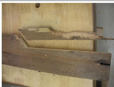
Kahjustunud osa välja lõikamine tagaseina postil
