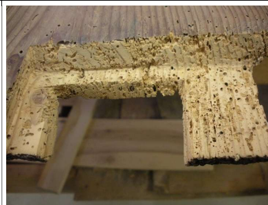
Kahjustunud osa välja lõikamine
