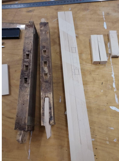
Fotod 11-12. Vasaku külje sari murdunud tapikeele taastamine.
