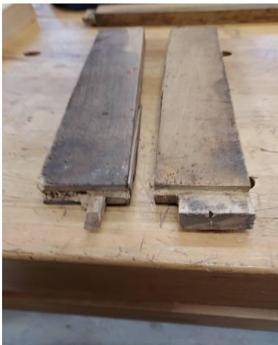
Fotod 9-10. Vasaku külje sari murdunud tapikeele taastamine.
