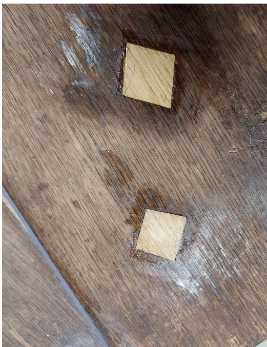
Fotod 6-7. Kapi pealisplaadi spooni parandustööd.
