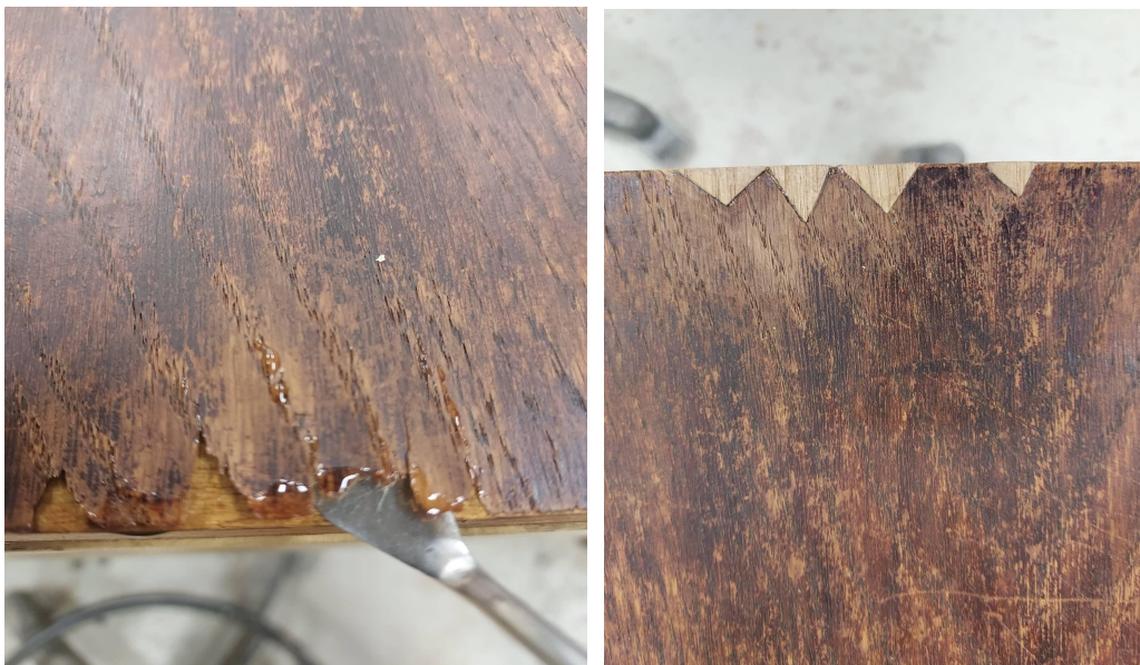
Fotod 12-13. Vasaku ukse alumise ääre spooni parandustööd.
