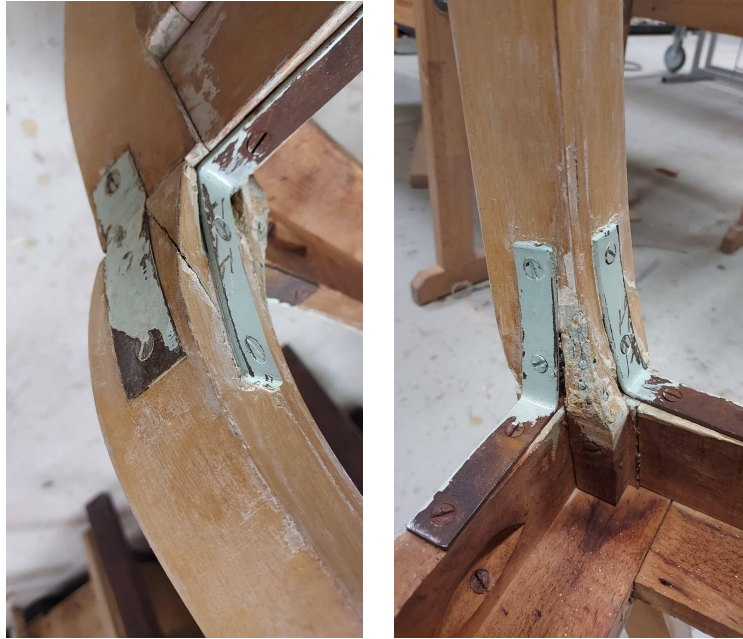
Fotod 4-5. Tooli esijalad on kinnitatud raami külge kruvide ja metallplaatidega. Jalgadel on palju murdumisi. Murdunud tapikeel on kinnitatud raami külge väikeste naeltega.
