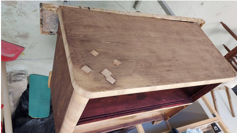
Fotod 15. Kapp on spoonitud ja lihvitud, valmis viimistluseks.
