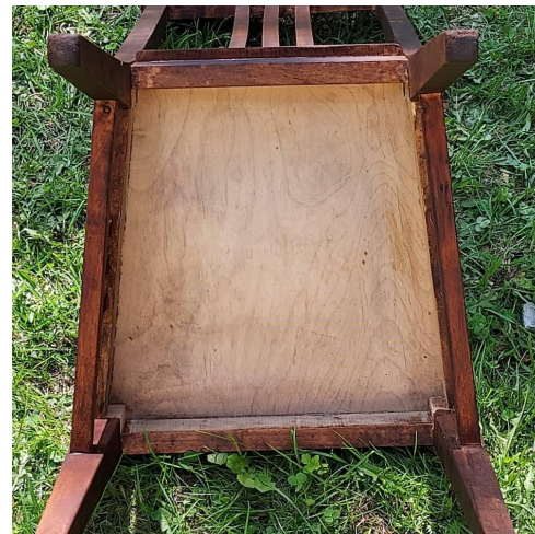
Fotod 33-34. Restaureeritud tooli vineerist põhjaplaat pealtvaates ja altvaates.
