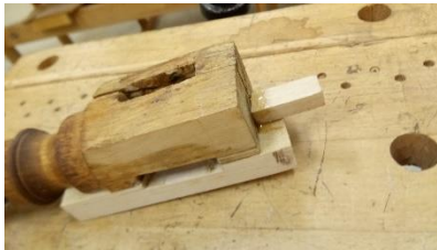
Pilt 12–21, puitosade parandamine ja asendamine
