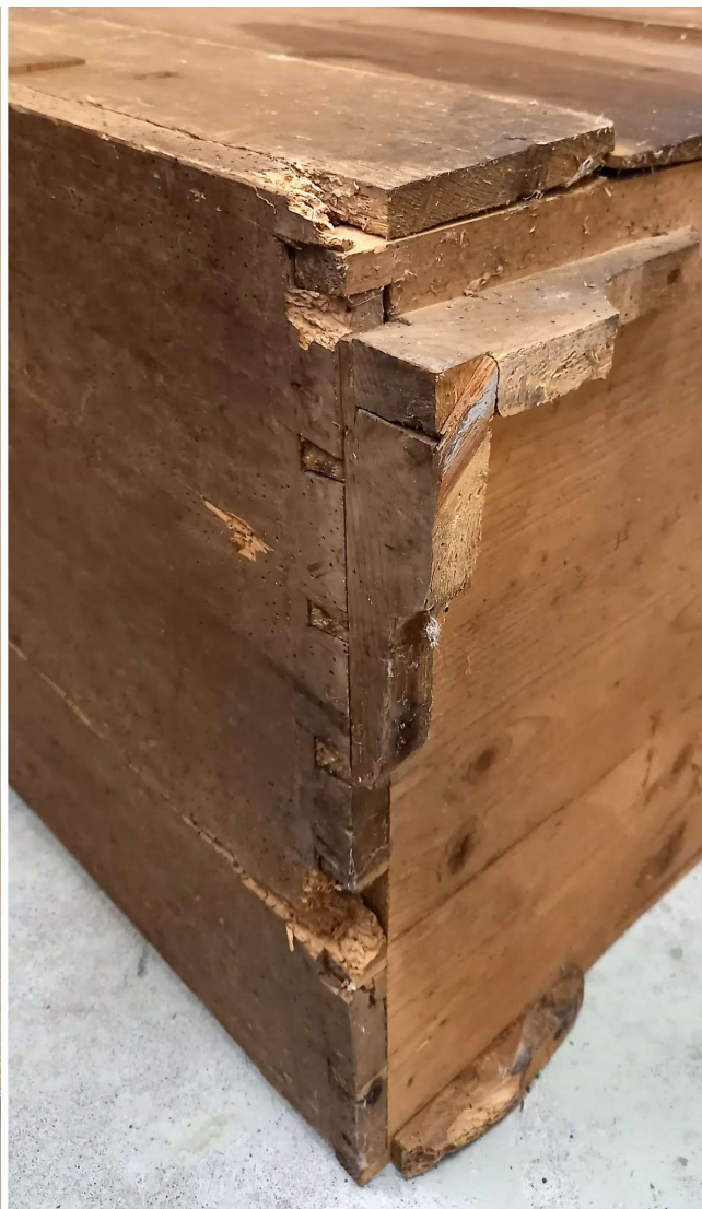
Foto 29 – Detailid putuk-kahjustustest kapi seinal ja jalgadel
