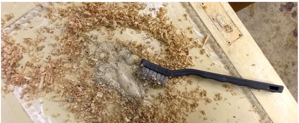
Foto 69 – Pinna puhastamine värvieemaldusvahendi, metallharja ja saepuru abil
