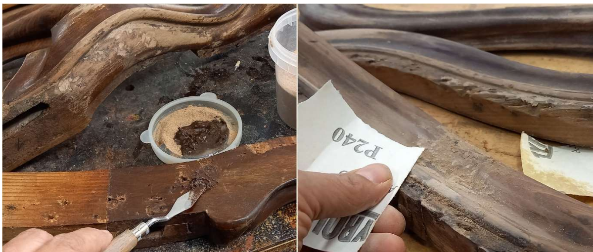
Foto 133 – puidupahtli peale kandmine ja hilisem lihvimine
