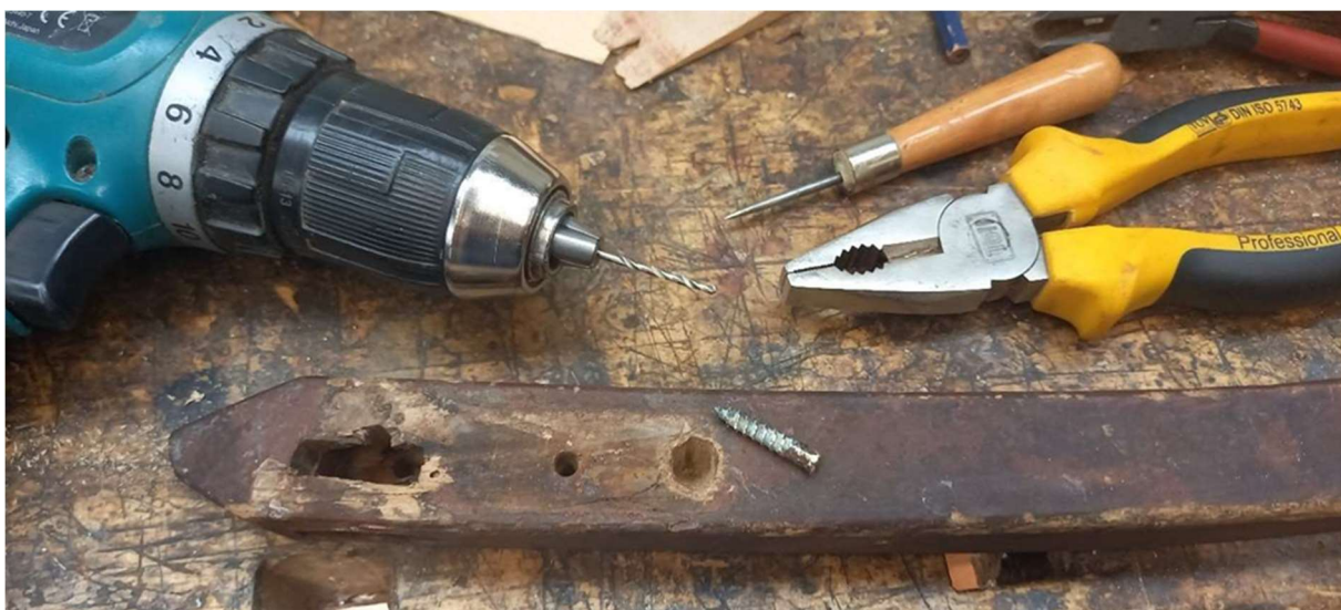
Foto 173 - Maha saetud kruvist jäi puidu sisse suur ava, see tuli hiljem puupunniga täita
