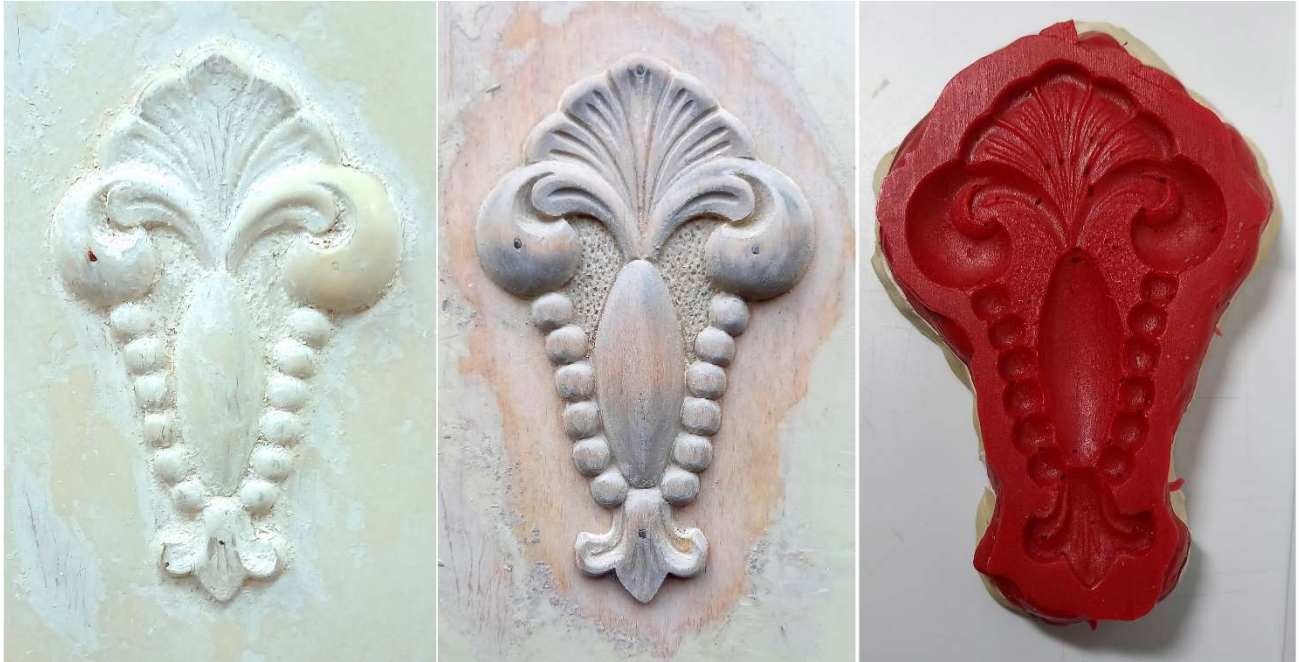
Foto 70 – Ornament enne ja pärast puhastamist ning vinamoldist vorm jäljendi valamiseks
