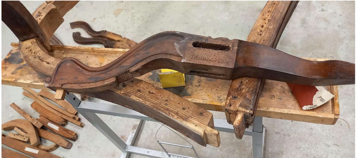
Foto 130 – tapikeelte ja pesade puhastamine ning lihvimine enne raami monteerimist
