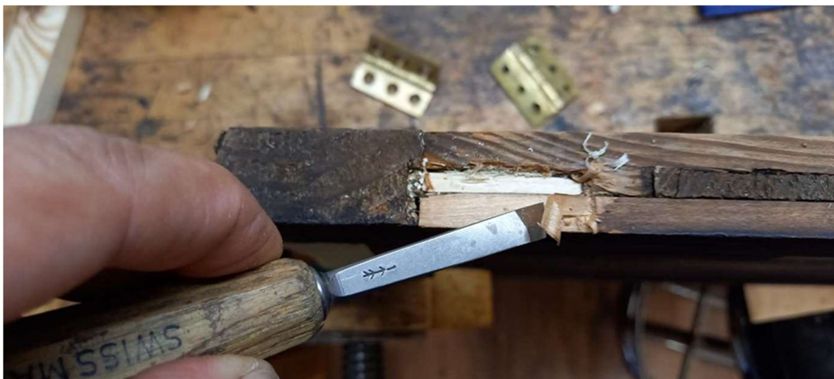
Foto 206 – uksehingede pesa parandamine
