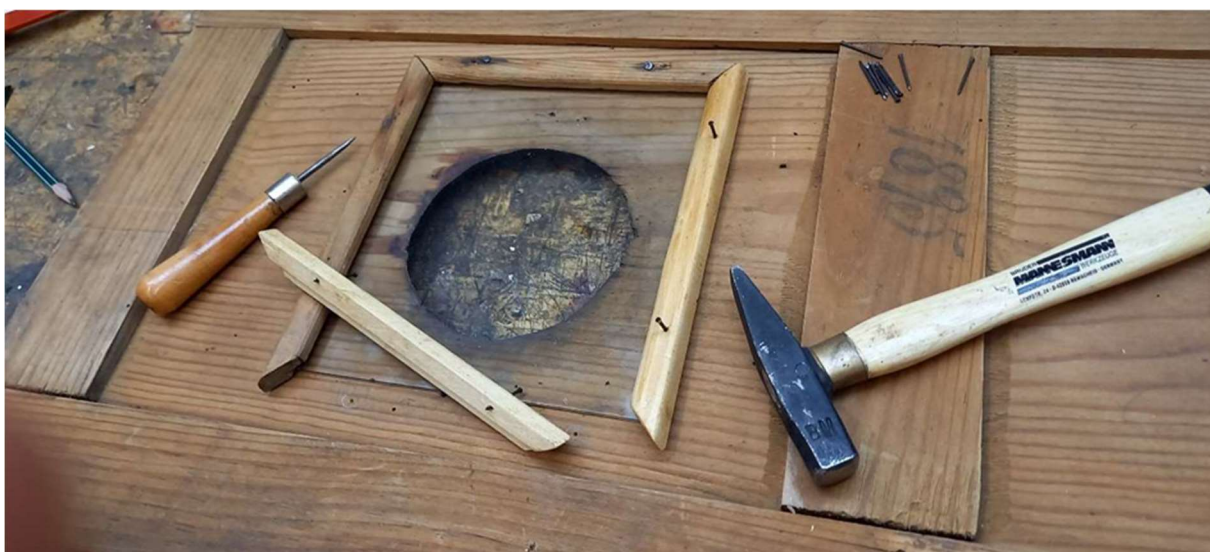
Foto 203 – kapiukse klaasi liistude kinnitamine
