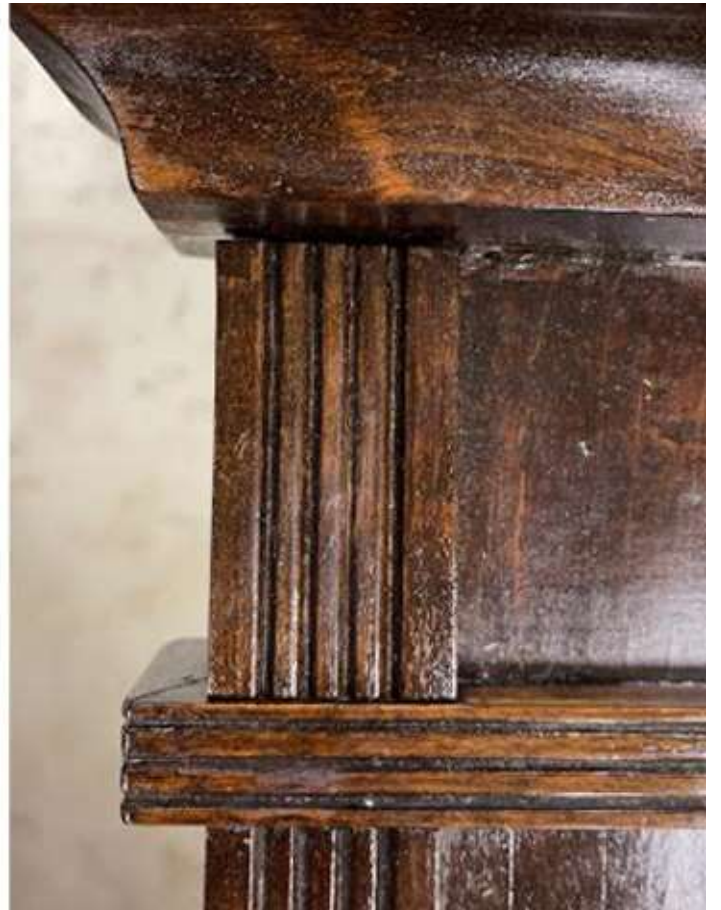
Foto 60 - Iluviga raamil enne ja pärast vahapulgaga täitmist
