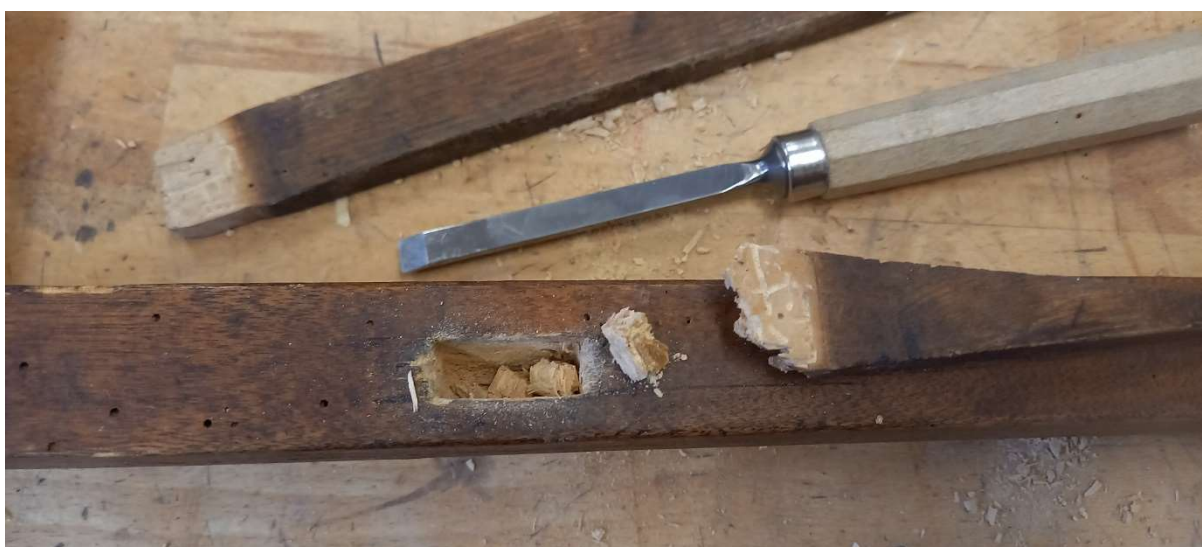
Foto 98 – katkine tapikeel ja puhastamist vajav tapipesa
