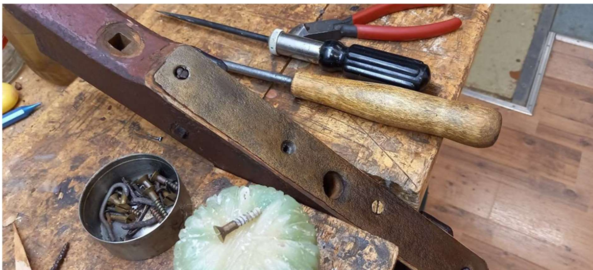
Foto 189 -- Kruvide tagasi keeramisel oli abi küünlavahast
