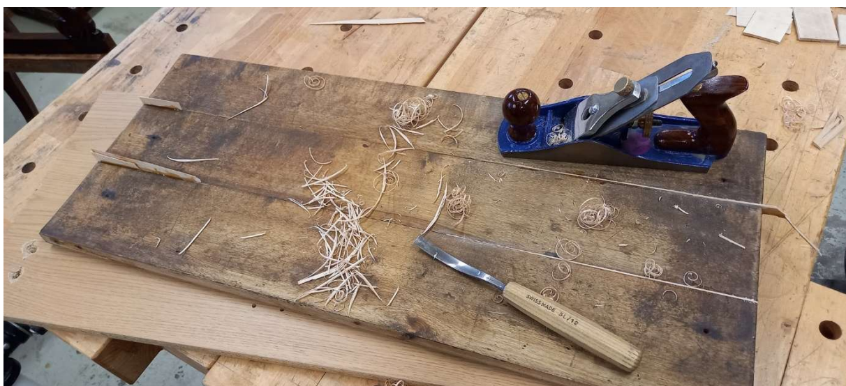
Foto 91 – Lauaplaadi vaheliste pragude kokku surumine ja tihendamine
