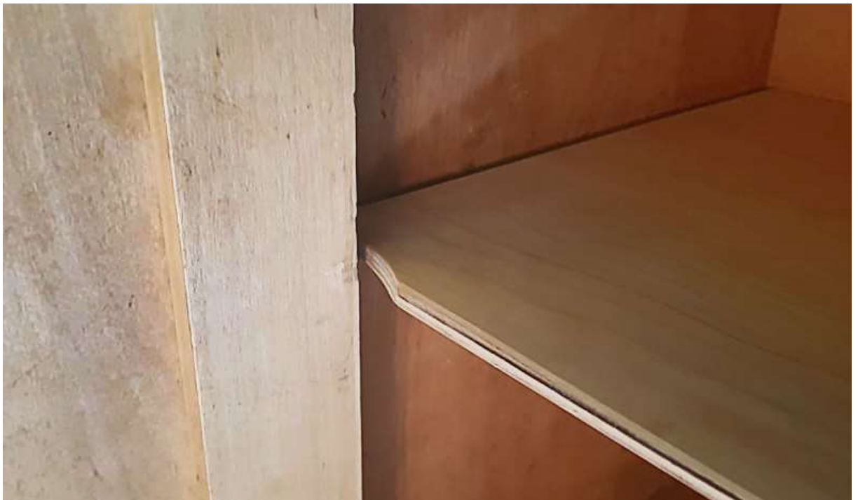
Foto 77 – Kapi riulile on tehtud kerge sisselõige, et säästa riuli pinda ning et uks mahuks vabalt liikuma
