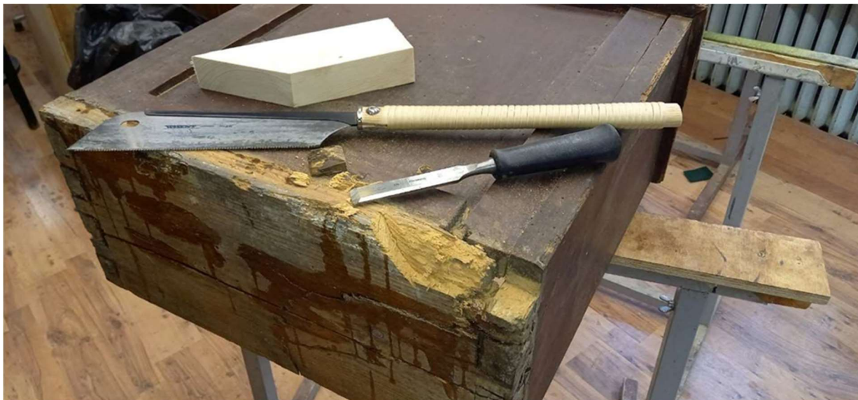
Foto 197 -- Kapi nurgas asuvale panustükile pesa välja saagimine ja täpselt peiteldamine
