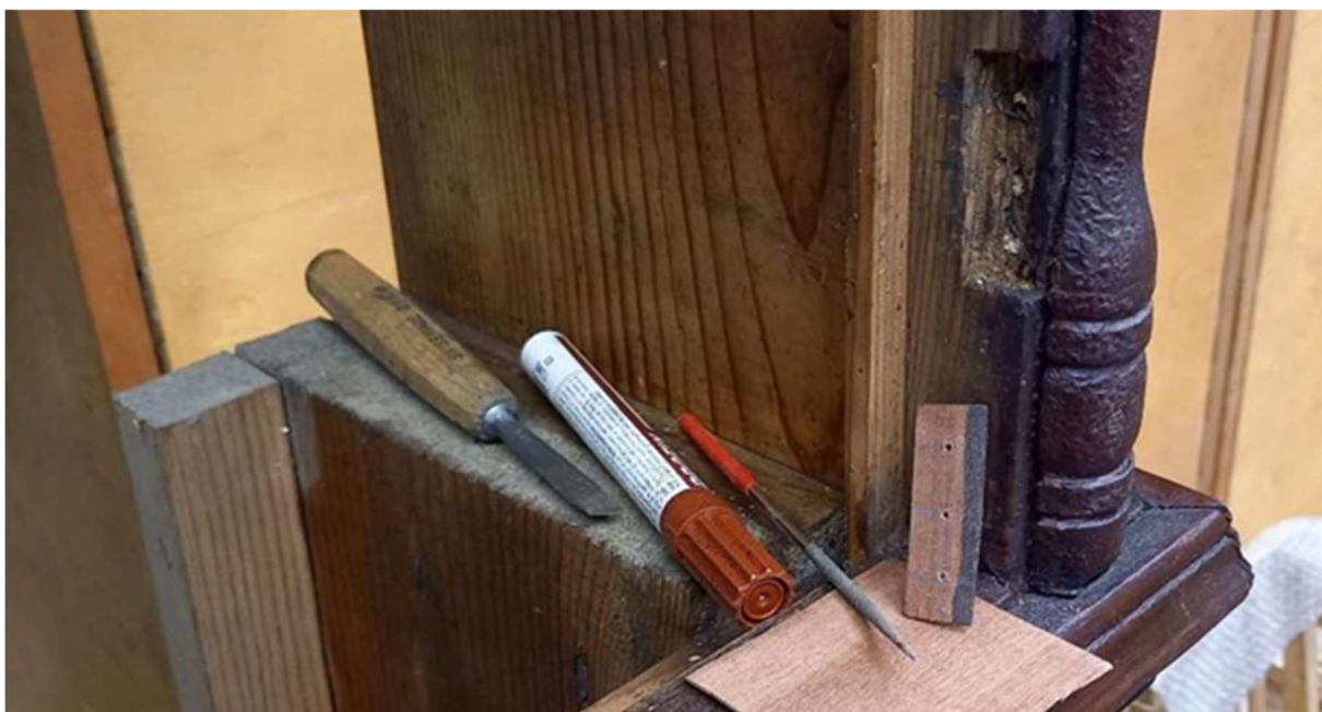
Foto 205 – spoonitüki paigaldamine uksehinge vahele
