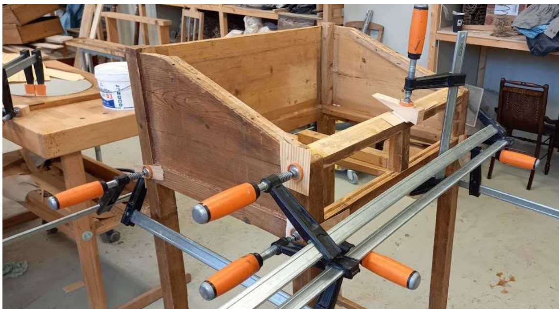
Foto 90 - Konstruktsioon on pitskruvidega kinnitatud kuni liimi kuivamiseni
