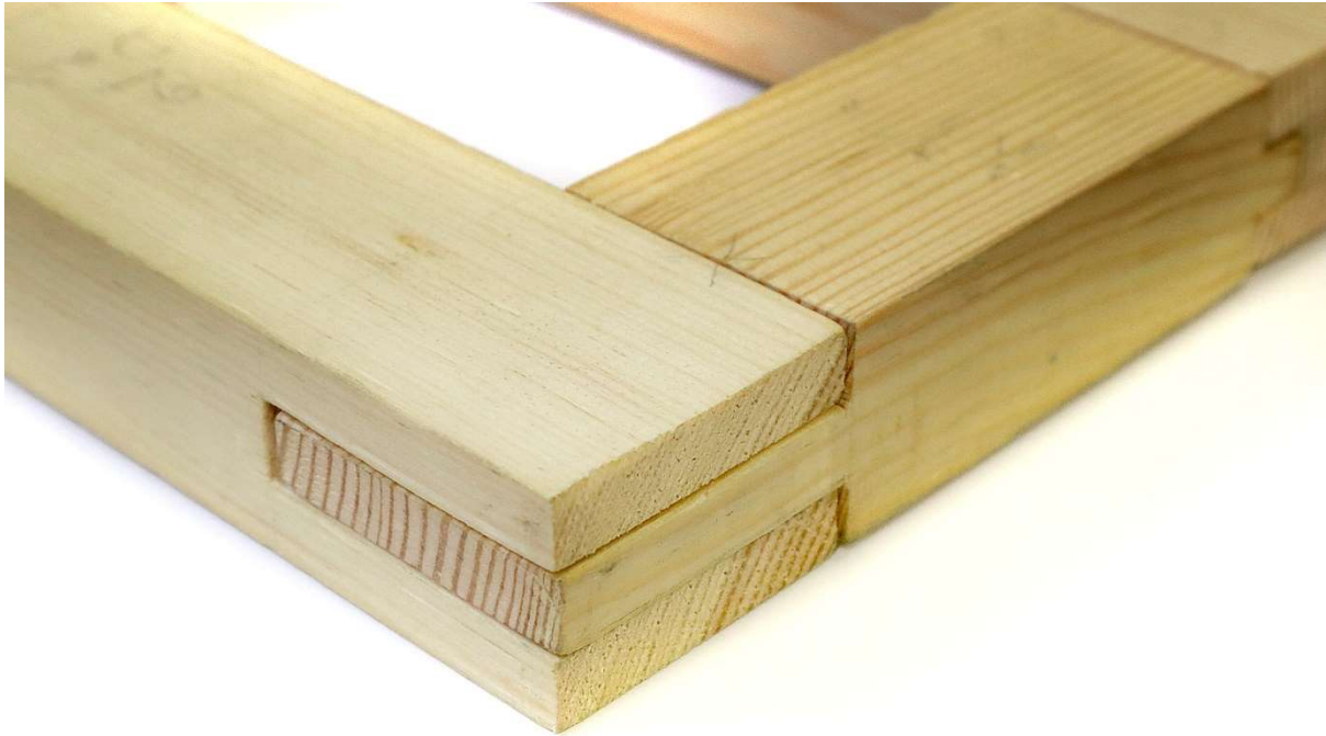
Foto 6 – detail tapiraamist, harktapp
