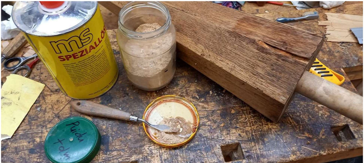
Foto 224 - -- oksaugu tasandamine puidutolmust valmistatud pahtli abil
