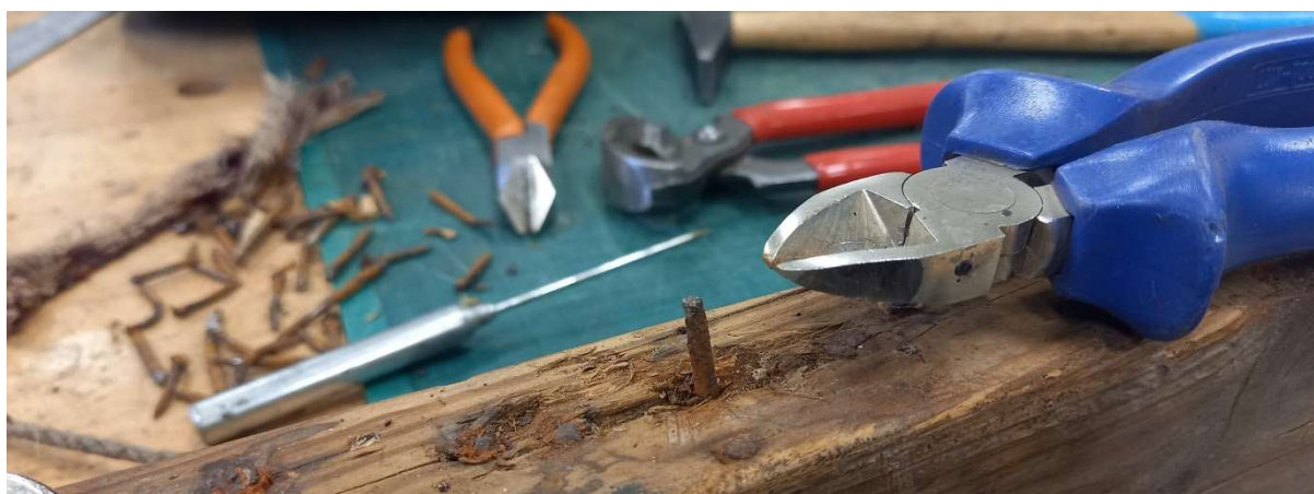
Foto 121 – naelapead murdusid välja tõmbamise käigus tihti
