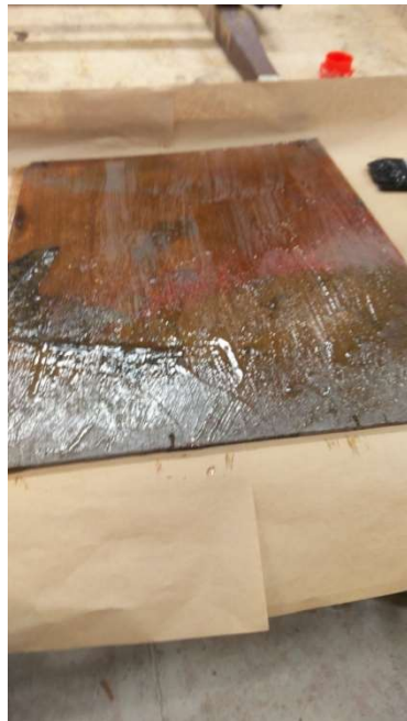
Vana värvi eemaldamine Vivacolor puhastusainega, kaabitsaga kaapides.
