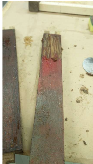
Vana värvi eemaldamine Vivacolor puhastusainega, kaabitsaga kaapides.
