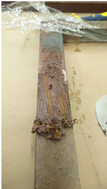
Vana värvi eemaldamine Vivacolor puhastusainega, kaabitsaga kaapides.
