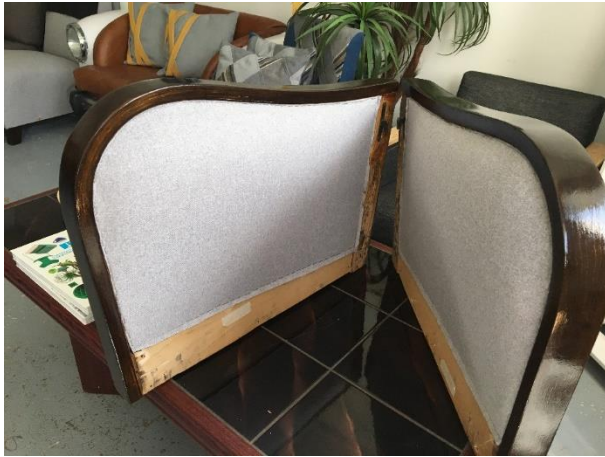
Käetugede välisküle alumine serv on jäetud lahti, käetugede tugitooli külge kruvidega kinnitamiseks
