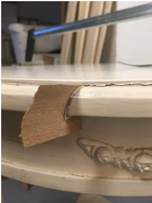
Vineerplaadi all oleva originaalplaadi lahku kuivanud välisserva praod täitsime spooniga. Alumise lauaplaadi katkised kohad liimisime ning paigaldasime tüüblid.
