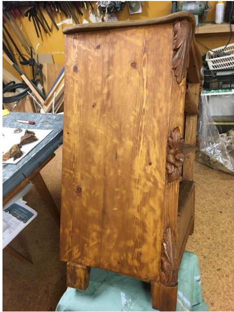
Kummuti külg peale peitsimist (näha lihvmasinga tekitatud vorbid)
