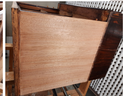
Kapi külg kaetud mahagoni spooniga. Spoonikihtide ühtlustamiseks kasutasime triikrauda ja lihvklotsi.
