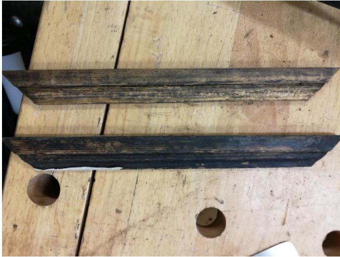
Pilt 8 Kapi tahvli iluliistud. Ülemine kaaplehega puhastatud, alumine ootab puhastust .
