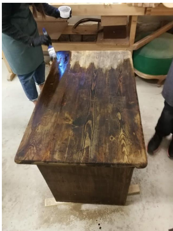
Pilt 17 Laua plaat peitsimisel
