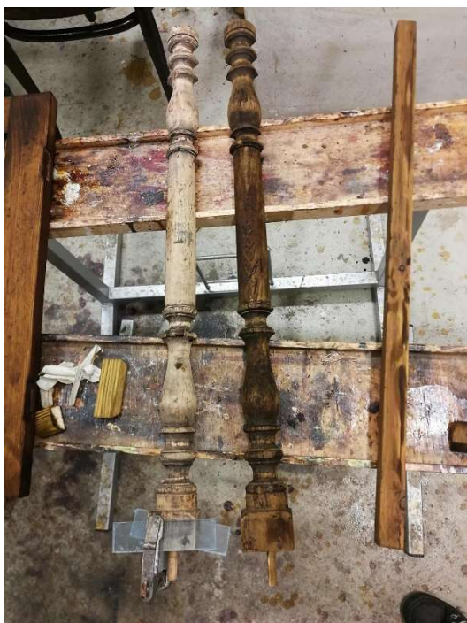
Kapi ja detailide peitsimine vee baasil peitsiga, tooniks on hele pähkel. Peale kuivamist kruntimine.
